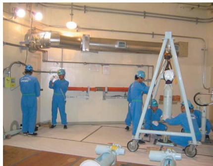
ナトリウム抜き取り用モーター弁据え付け作業(原子炉建物内にて)
